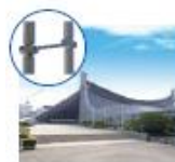
国内初、鑄鋼品として建築物に採用された当社製品（国立代々木競技場のケーブルバンド）
