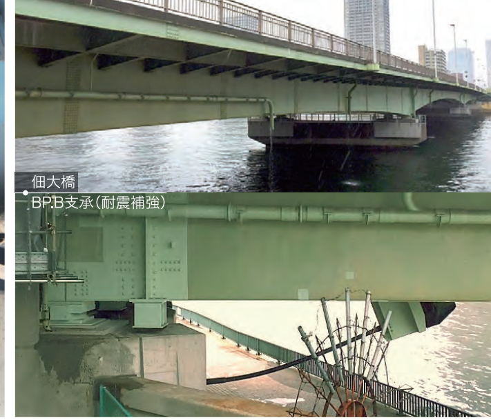
小松川JCT / BP.B支承(耐震補強)
