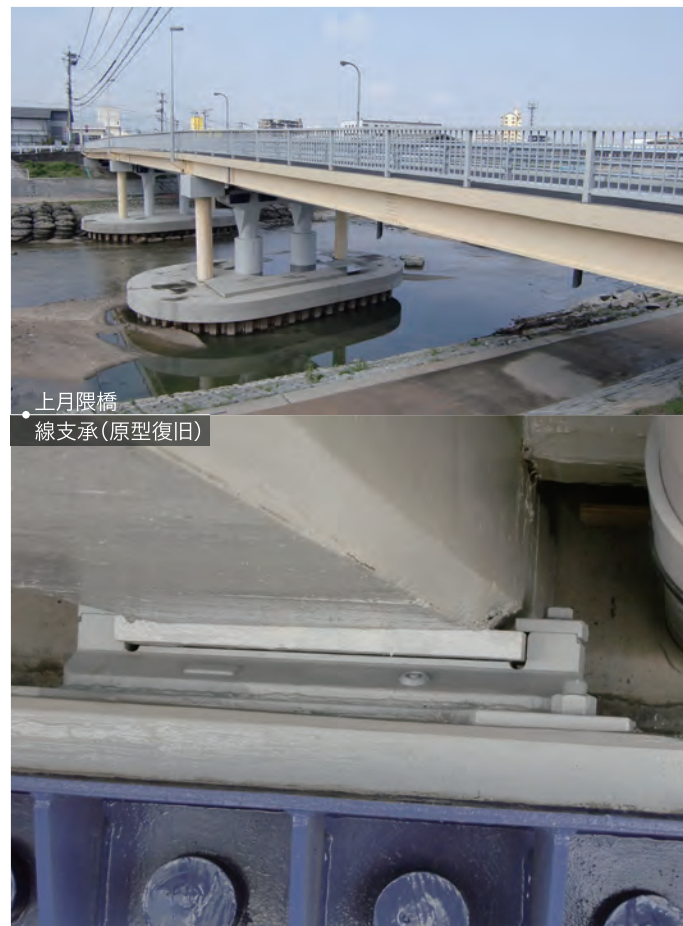
大島大橋 ピンすべり支承(耐震補強)
