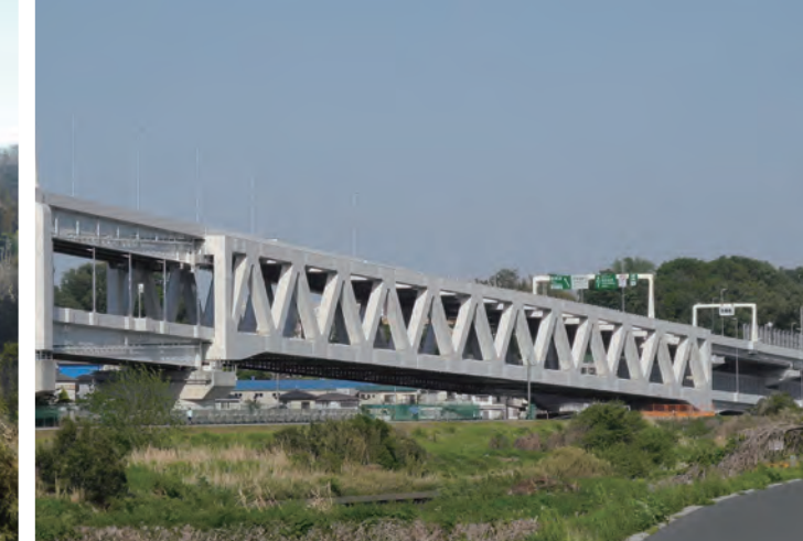
大熊川トラス橋 / 免震ゴム支承
