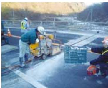
1. 既設ジョイント 撤去①
