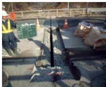
2. 既設ジョイント 撤去②
