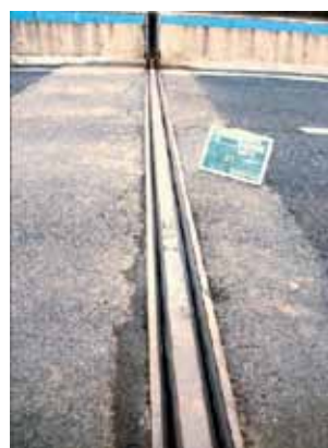
3. シールゴム取替え完了
