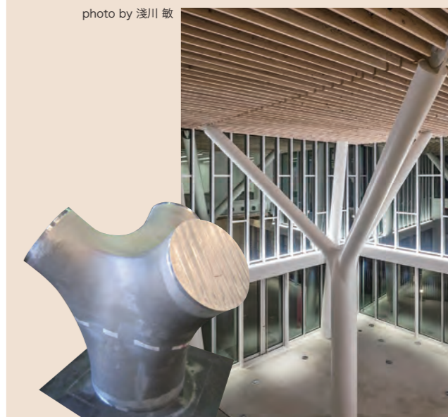
柱頭分岐接合部 (明治大学中野キャンパス)
