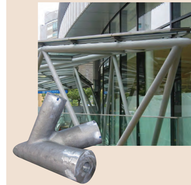
トラス接合部
