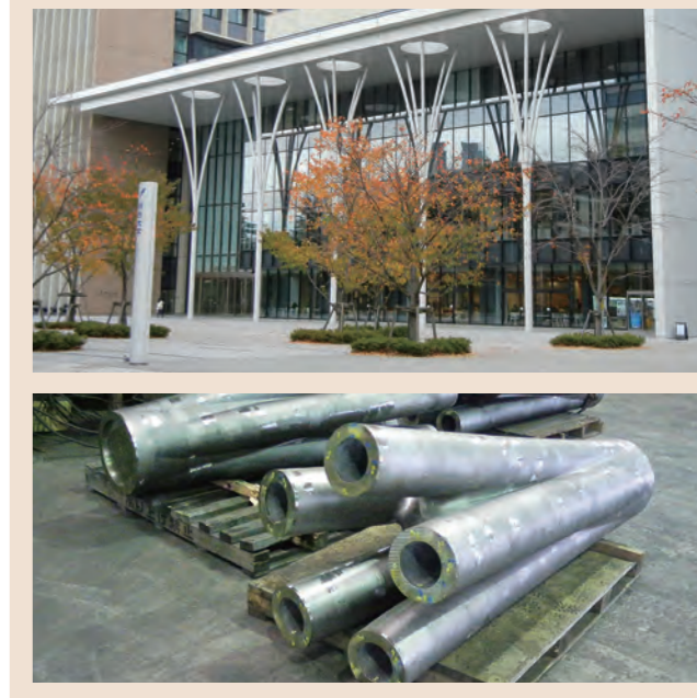
柱頭分岐接合部 (明治大学中野キャンパス)
