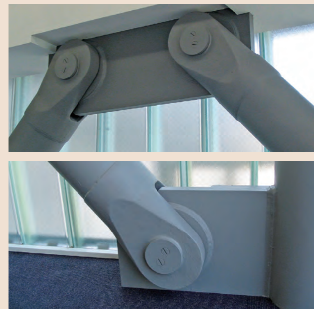
ブレース端部
