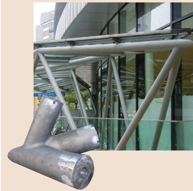
桁架结构连接部
