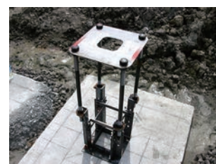
現場組立完了
