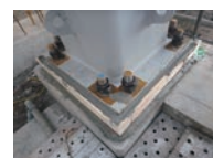
中心塗りモルタル・上下ナット
