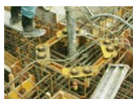
コンクリート打設
