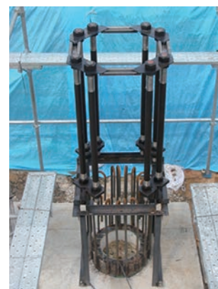
現場据付完了
