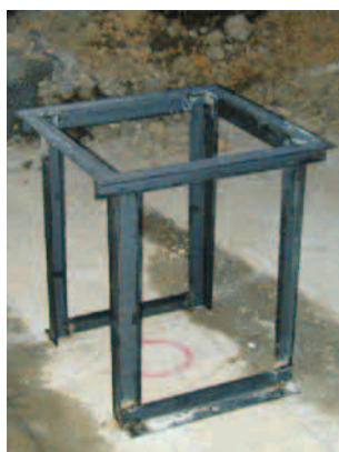
現場架台組立
