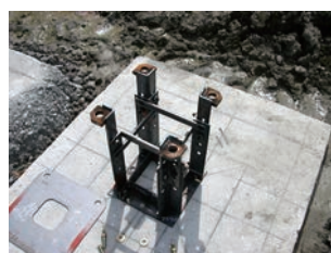
現場架台取付
