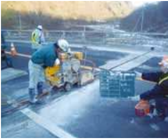
1. 既設ジョイント 撤去①
