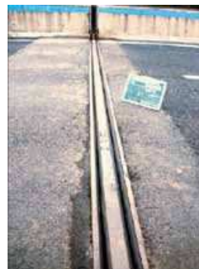
3. シールゴム取替え完了
