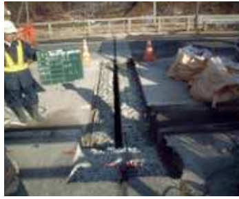
2. 既設ジョイント 撤去②
